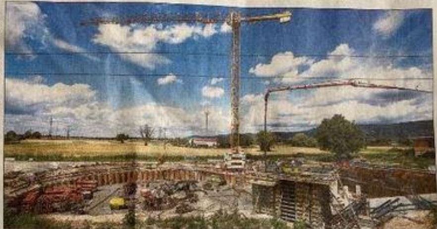
Im Nordwesten der Kläranlagen-Gelände des Abwasserzweckverbands Untere Hardt entsteht derzeit eine neue Reinigungsstufe. Die zusätzliche Anlage entspricht dem modernsten Standart zur Eliminierung von Phosphorverbindungen und Spurenstoffen. Foto: Nies
