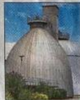
Im Faulbehälter zersetzt sich mit der Zeit der Klärschlamm, woraus Energie gewonnen wird.
